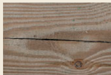
Spanningsscheurtjes door de houtdroging
